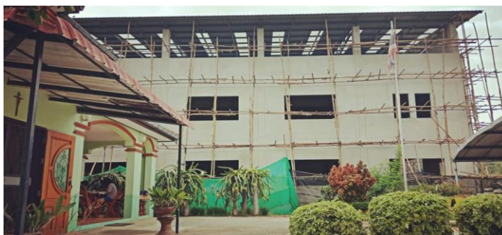
Il nuovo edificio per aumentare la capacità di accoglienza - 2021
